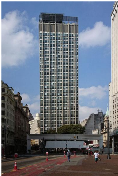
Figura 2: Skidmore, Owings & Merrill, Jacques Pillon e Giancarlo Gasperini: Edifício Barão de Iguape, São Paulo, 1956. Fonte: Foto Hugo Segawa, 2018.
