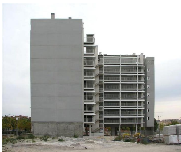
Figura 14: Paulo Mendes da Rocha + Javier Bellosillo: edifício residencial em Vallecas, Madrid, 2004. Fonte: Foto Hugo Segawa, 2007.
