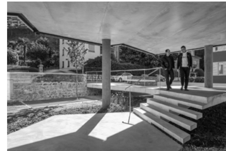
Angelo Bucci e o engenheiro suíço Andrea Pedrazzini sob o piloti do edifício em Lugano. Foto: Nelson Kon.
