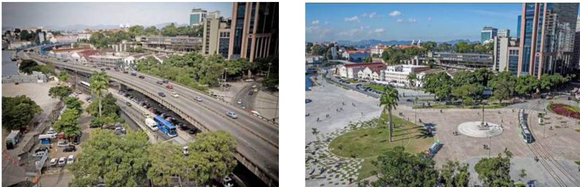
FIGURA 1 e 2 – A Praça Mauá e a entrada do Pier (à esquerda nas fotos), antes e depois da demolição da Av.
