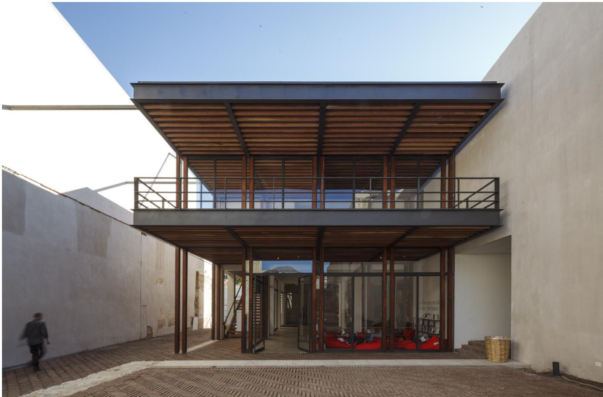
Imagem 3: Centro Cultural San Pablo. Fonte: Luis Gordo. https://www.plataformaarquitectura.cl/cl/783799/centro-academico-y-cultural-san-pablo-taller-de-arquitectura-mauricio-rocha-plus-gabriela-carrillo
